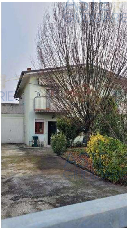
Ingresso da via Parmala
