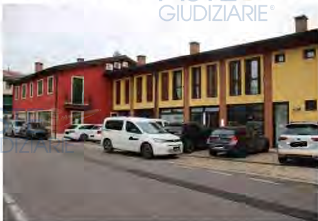
Vista dell'esterno dell'ufficio e dei posti auto
