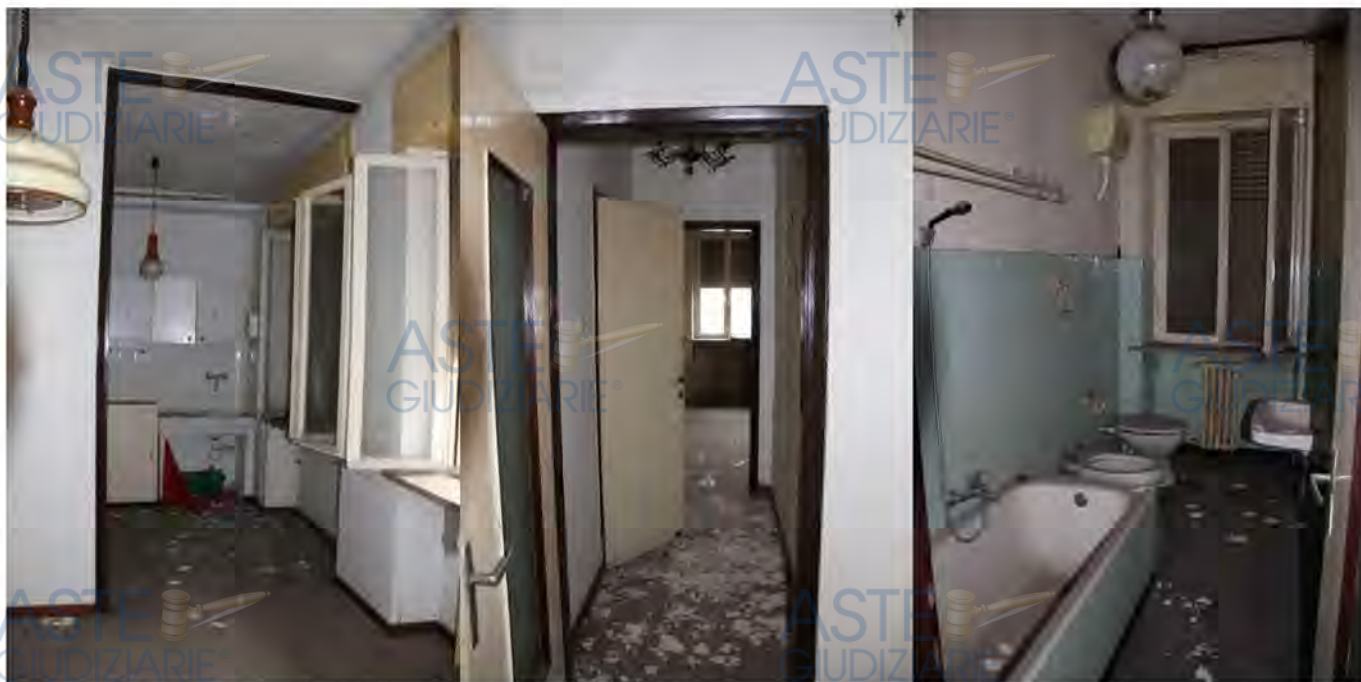
Viste dell'interno dell'edificio
