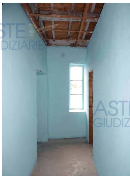
Locale disimpegno piano primo
