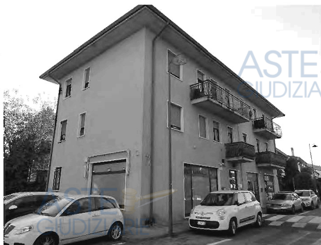
Vista angolare del fabbricato
