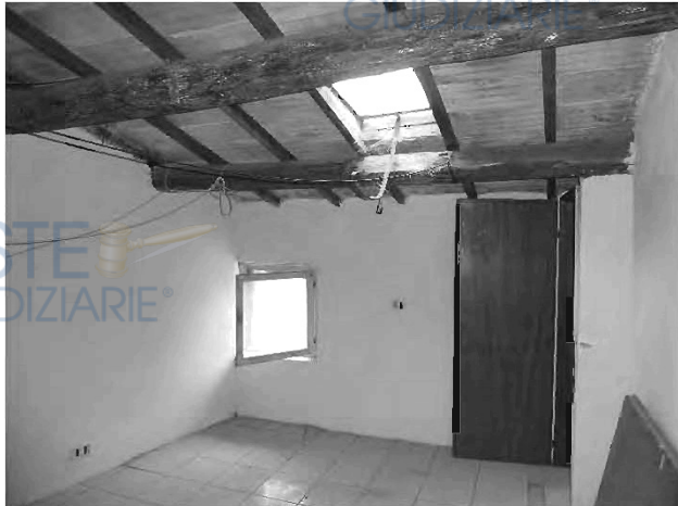
Locale soffitta piano secondo sottotetto
