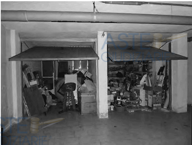
Locale autorimessa sub 13 piano interrato
