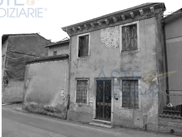
Fronte principale del fabbricato
