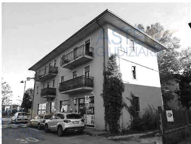
Vista angolare del fabbricato
