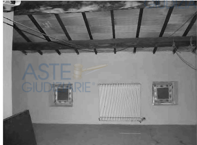
Locale soffitta piano secondo sottotetto
