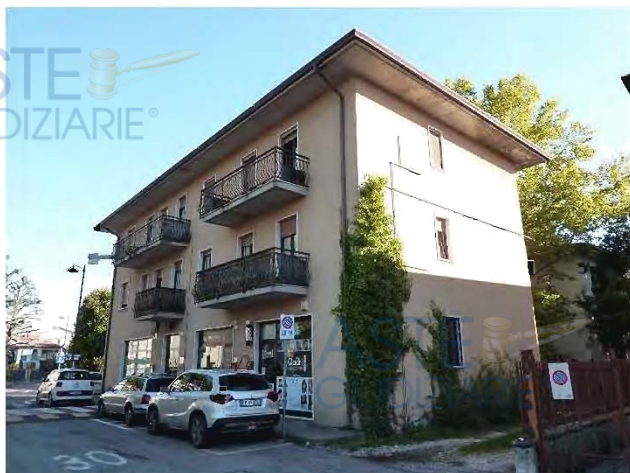
Vista angolare del fabbricato
