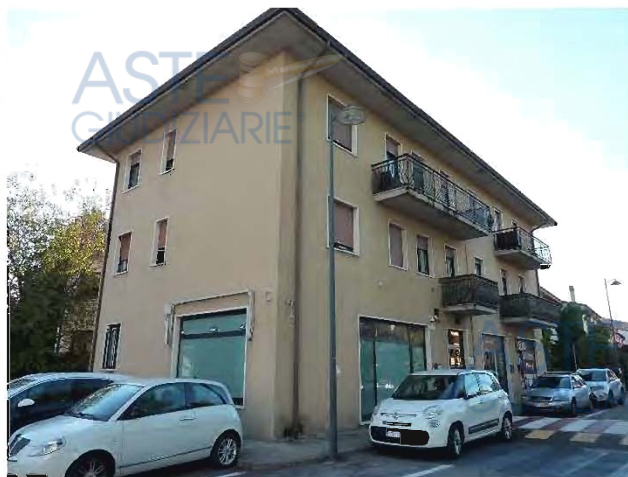
Vista angolare del fabbricato
