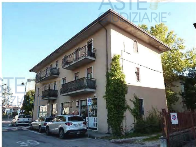
Vista angolare del fabbricato
