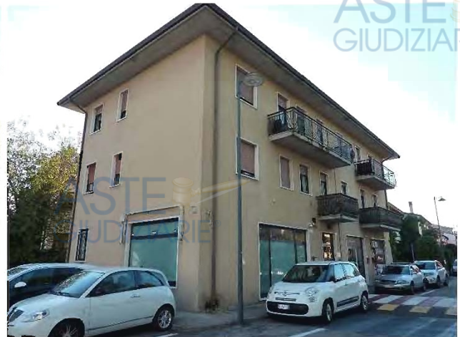
Vista angolare del fabbricato
