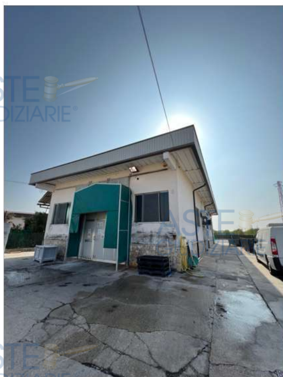
FOTO 6 - Fronte nord bene 1.a
