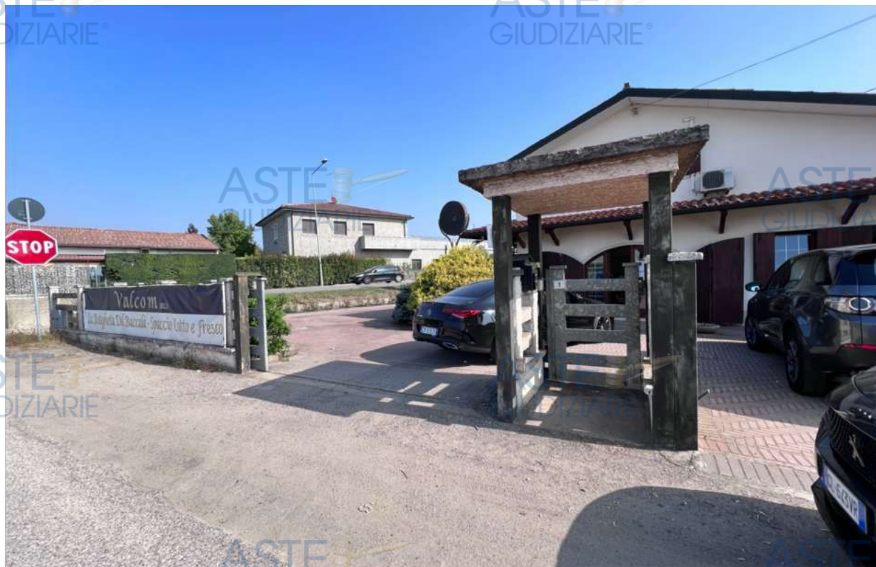
FOTO 5 - Fronte ovest bene 1.c - 1.d - 1.e
