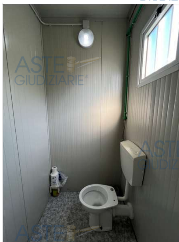
FOTO 20 - Bagno spogliatoio 1.a
