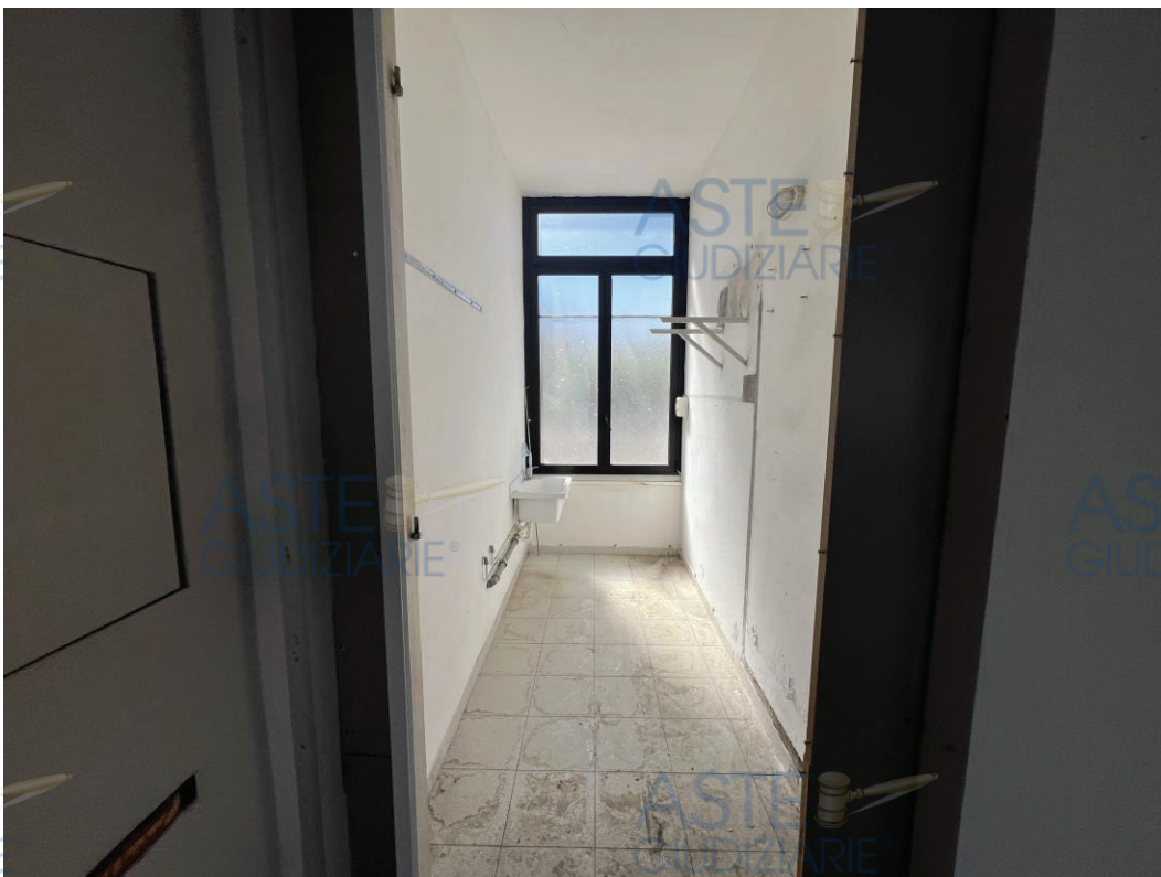
RIPOSTIGLIO (EX LOGGIA)
