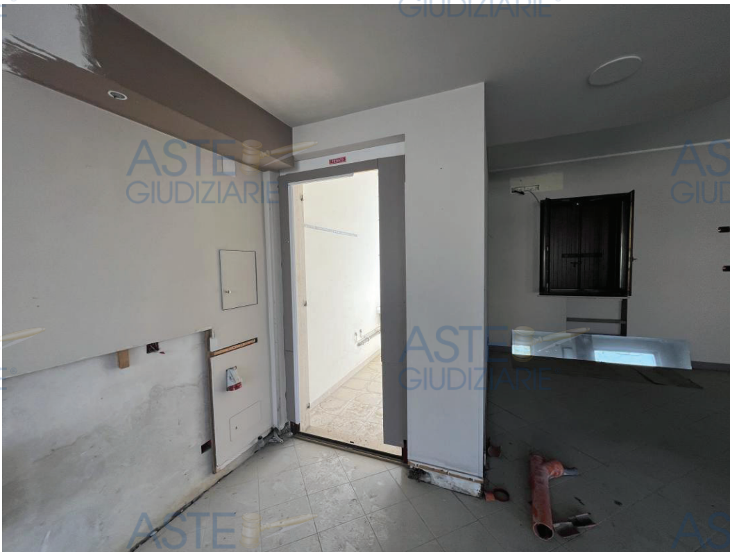
ACESSO AL RIPOSTIGLIO
