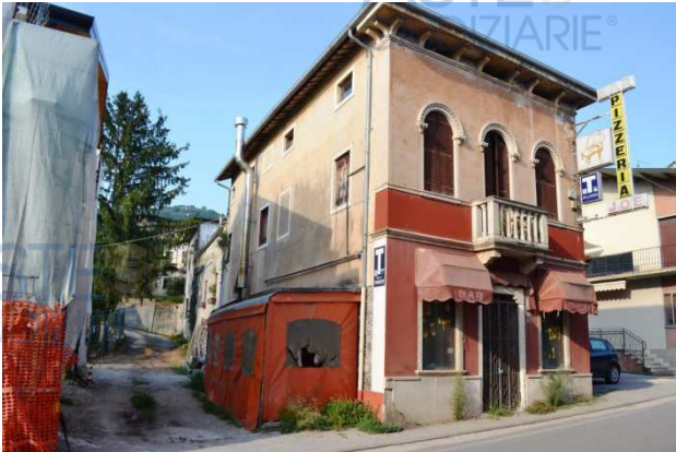
foto 1 - vista da sud est dalla parte sud dell'edificio fronte strada sul m.n. 253 con l'ingresso del bar/pizzeria al piano terra su via Roma e col fianco ovest dell'edificio prospettante sullo stradello sterrato (passaggio promiscuo) con l'ingresso al civ. 77 attualmente al centro del bar/pizzeria
