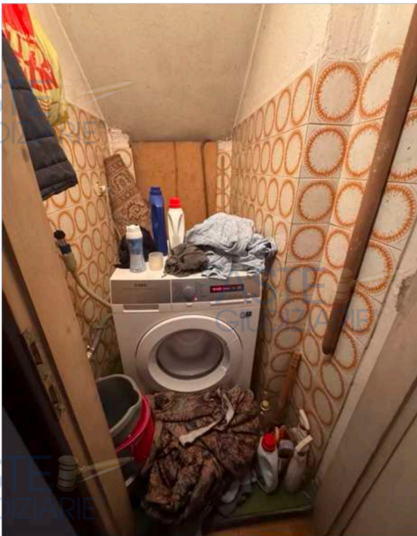
FOTO 3 - Lavanderia piano terra
