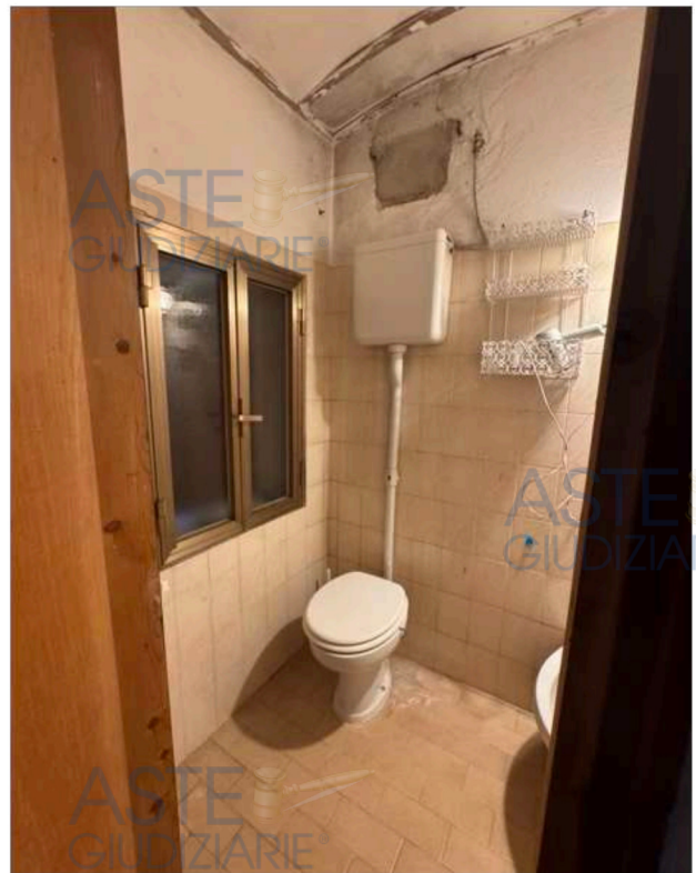
FOTO 11 - Bagno piano primo
