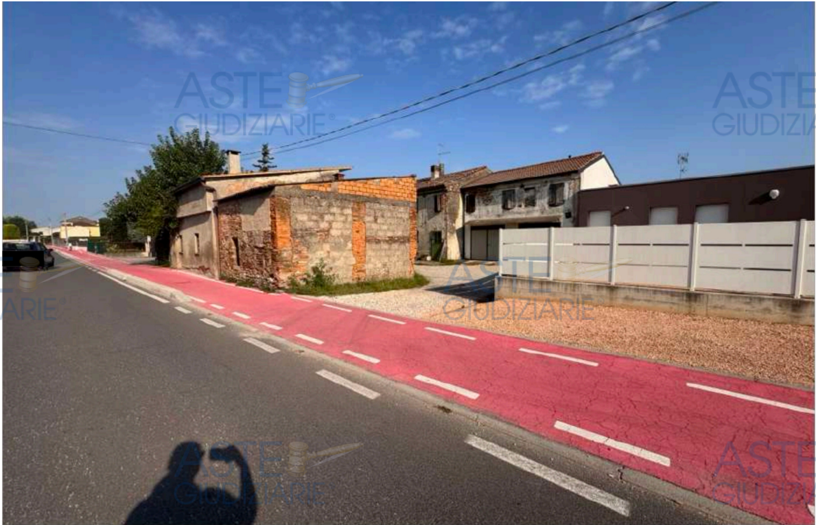
FOTO 1 – Fronte sud - accesso da via Cadelferro
