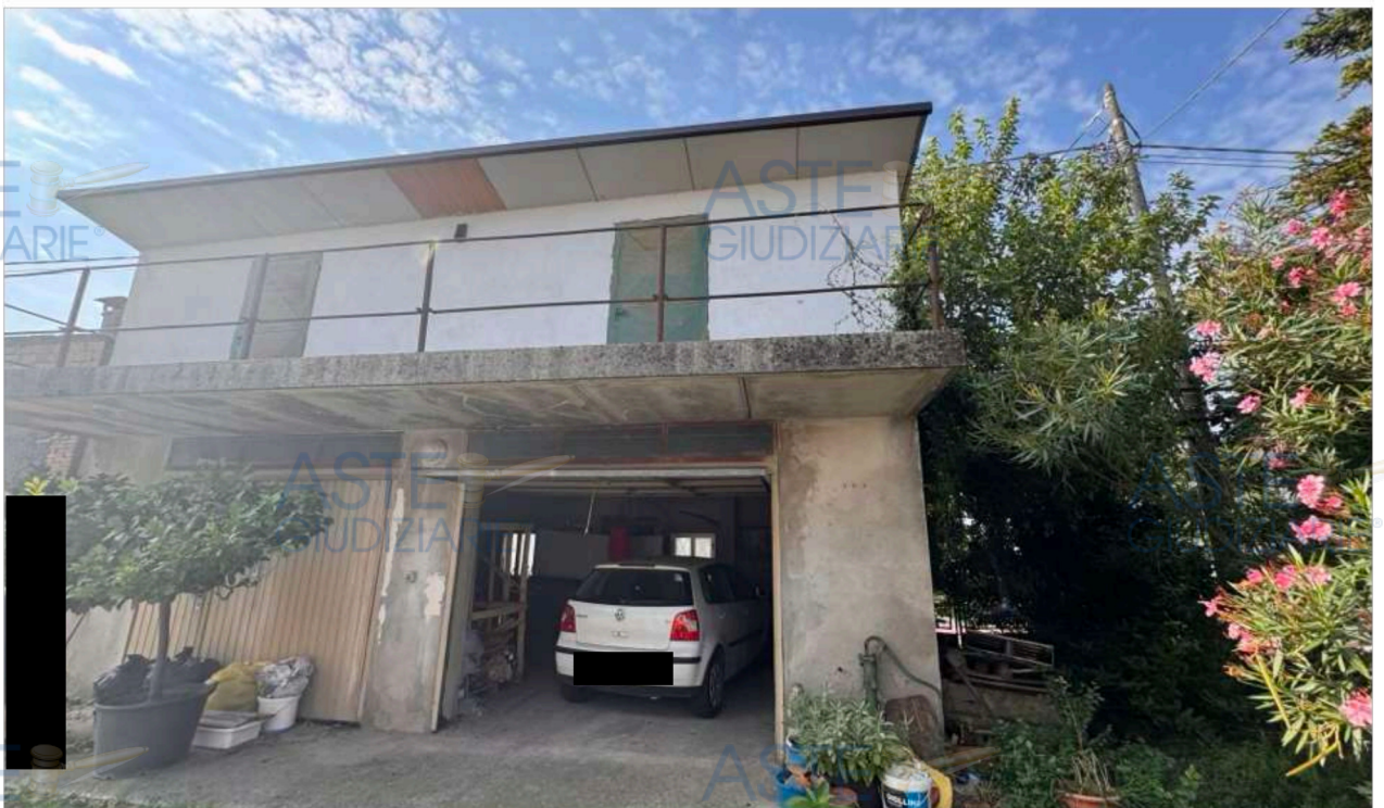
FOTO 4 - Fronte nord corpo autorimessa
