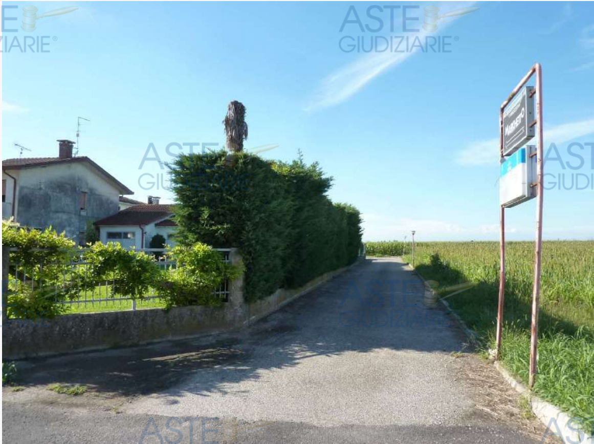
FOTO 5 _ VISTA LATERALE DEL COMPLESSO DA VIA CASEGGIATO
