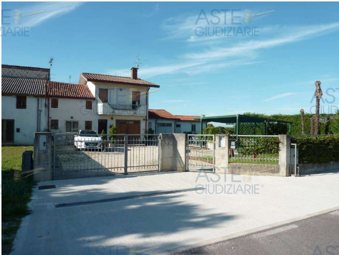
FOTO 3 _ VISTA DEL COMPLESSO IMMOBILIARE DA VIA CASEGGIATO – PROSPETTO SUD
