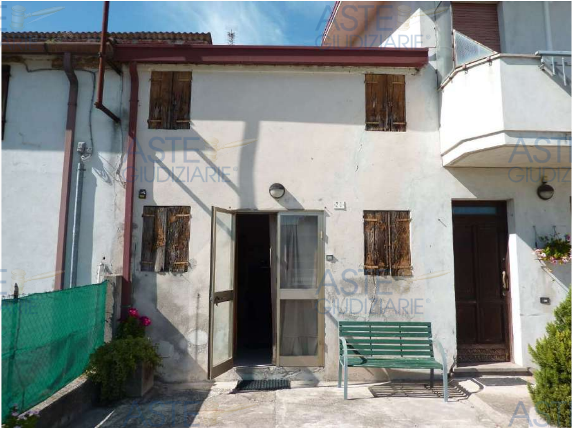
FOTO 9 _ DETTAGLIO FRONTE PRINCIPALE DELL'IMMOBILE SUB 5 DALLA CORTE PERTINENZIALE - PROSPETTO SUD
