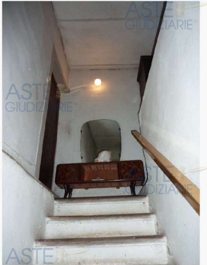
FOTO 9 _ VISTA INTERNA – SCALE DI ACCESSO AL PIANO PRIMO – APPARTAMENTO SUB 5
