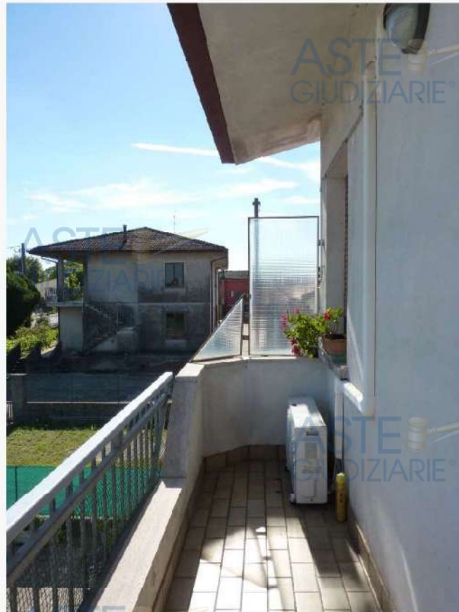
FOTO 20 _ BALCONE APPARTAMENTO SUB 6 – PIANO PRIMO
