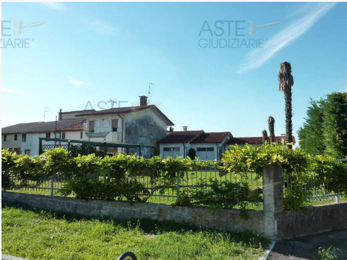
FOTO 4 _ VISTA DEL COMPLESSO IMMOBILIARE DA VIA CASEGGIATO – PROSPETTO SUD
