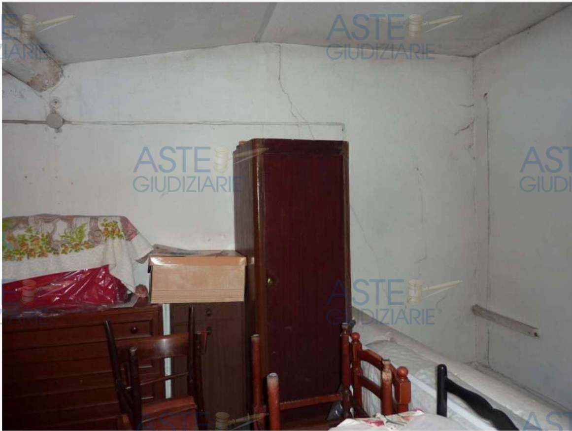
FOTO 11 _ VISTA INTERNA – CAMERA 01 APPARTAMENTO SUB 5 – PIANO PRIMO
