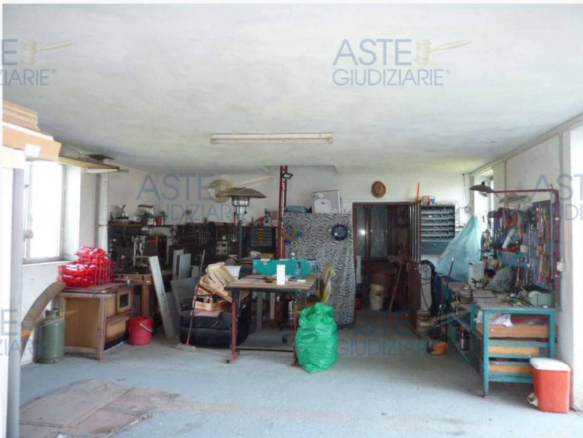
FOTO 32 _ VISTA INTERNA – MAGAZZINO SUB 8 – PIANO TERRA
