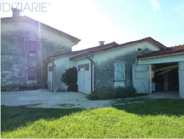
Vista del compendio dalla corte pertinenziale
