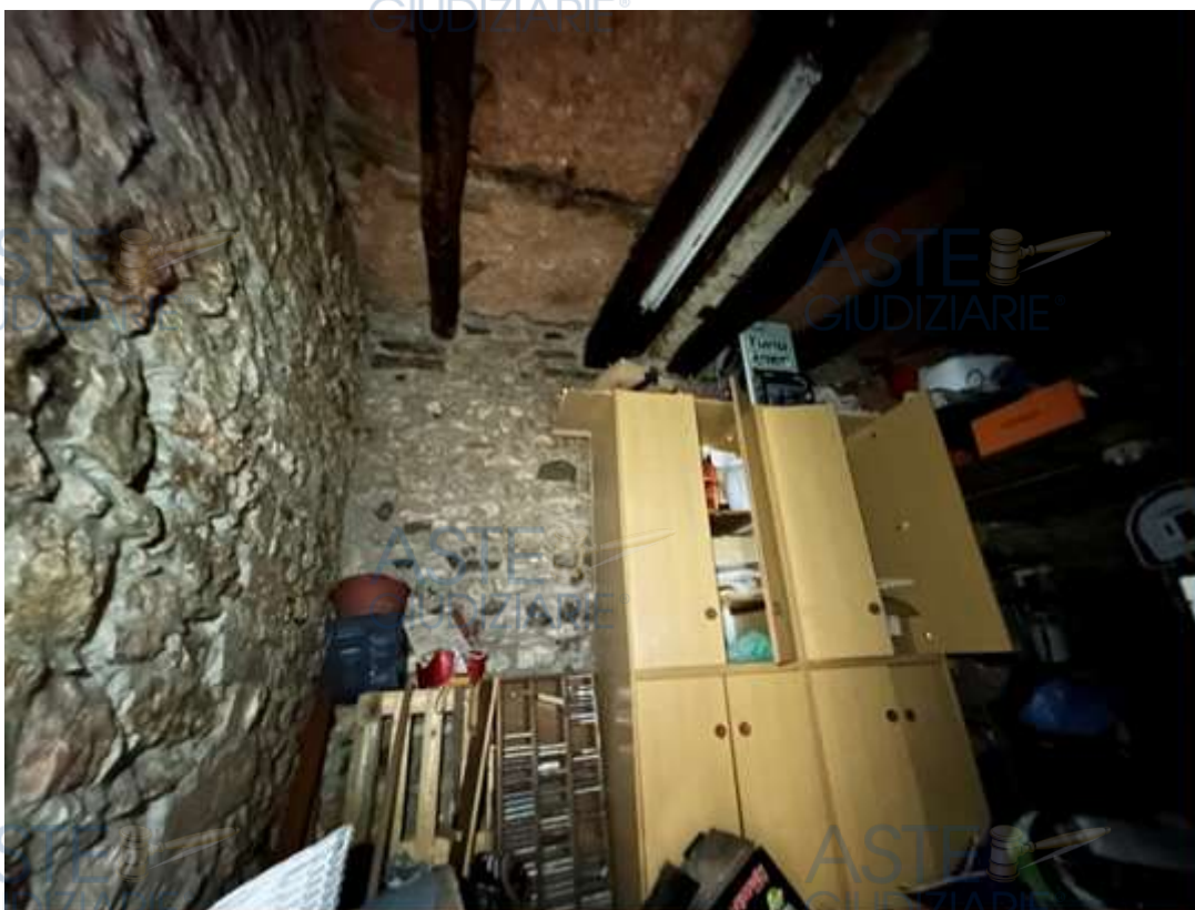
Figura 8: PT ripostiglio (sassi a vista, travi a vista, solaio in pietra, pavimento in pietra, senza finestre)
