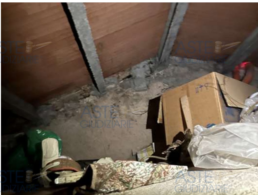
Figura 14: soffitta non agibile (accessibile da botola)
