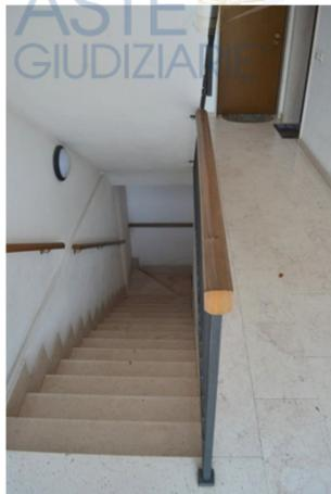
foto 4 - il vano scala comune sub 43 è finestrato piano per piano verso la strada, con aperture tali da sfruttare le piene luci architettoniche su quel lato. Le gradinate sono su solette rampanti. I rivestimenti sono in quadrotti marmorei smaltati; le finiture sono a tinte bianche
