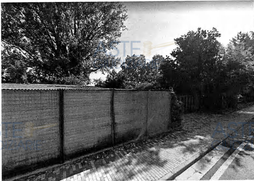
Esterni dell'unità mapp. 254 sub. 8
