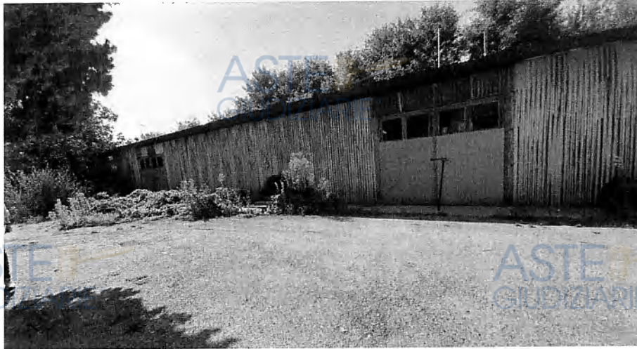
Esterni dell'unità mapp. 254 sub.9
