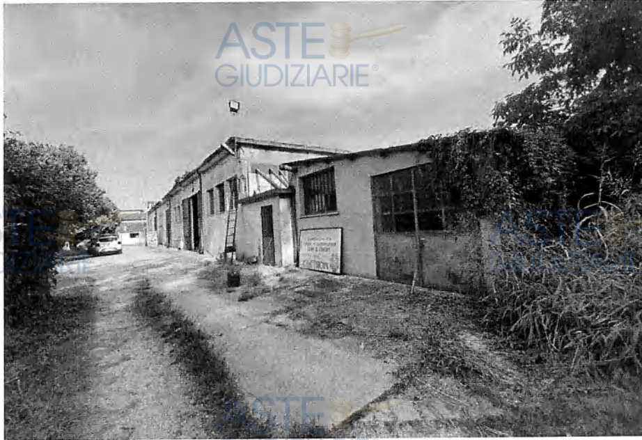
Esterni dell'unità mapp. 254 sub. 5
