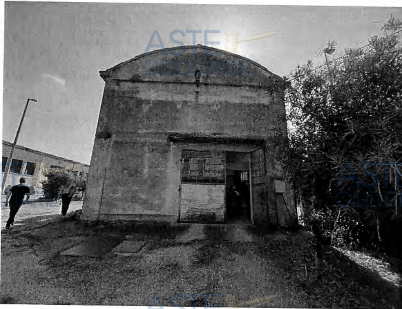
Esterni dell'unità mapp. 254 sub. 4
