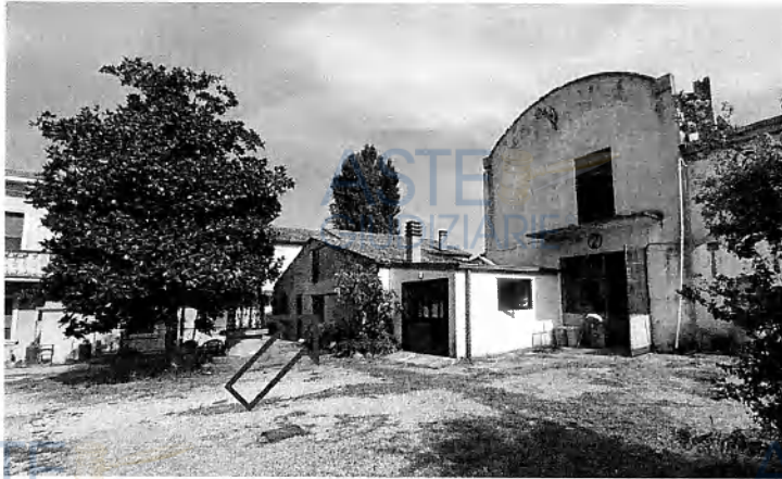
Esterni dell'unità mapp. 254 sub. 3 ripresi dal cortile comune e locale abusivo addossato sul fronte Est
