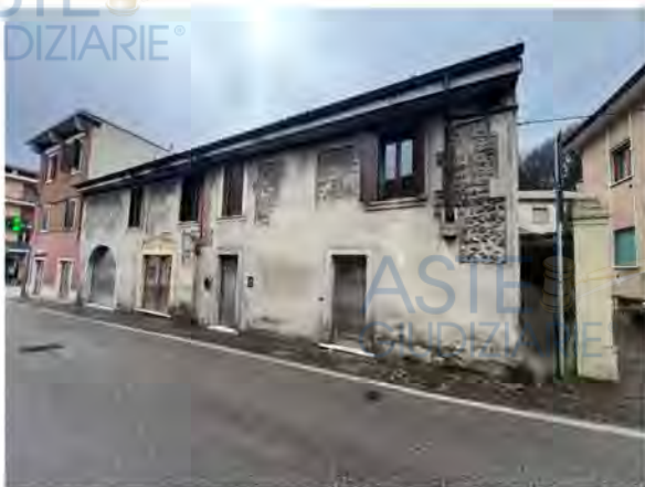
Vista generale esterna dalla via San Rocco
