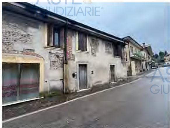
Vista generale esterna dalla via San Rocco
