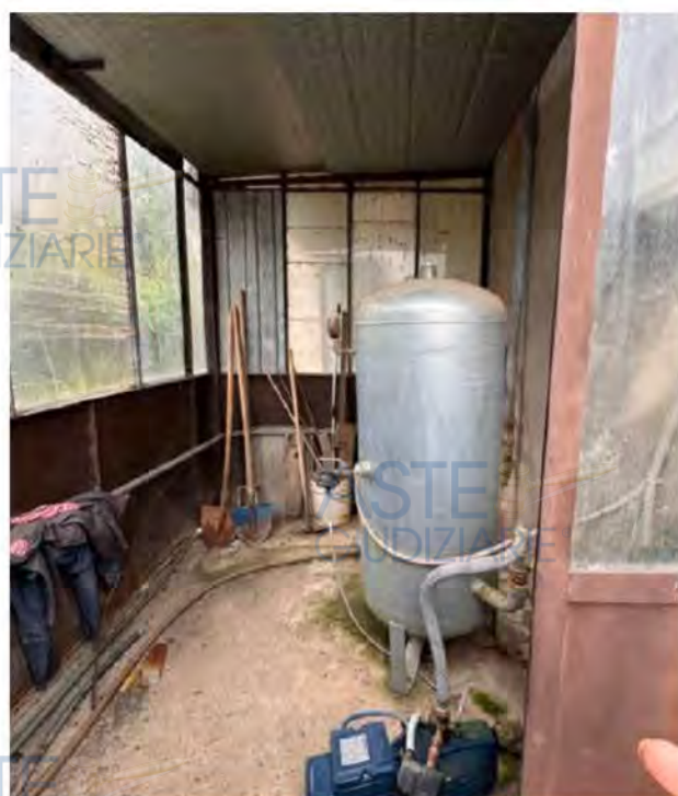
FOTO 6 - Autoclave pozzo - sub. 4 non oggetto di esecuzione
