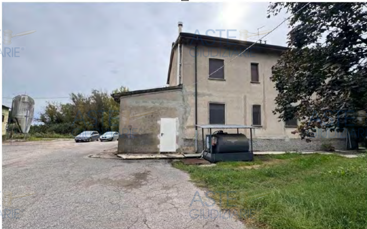
FOTO 2 - Fabbricato residenziale e autorimessa - retro
