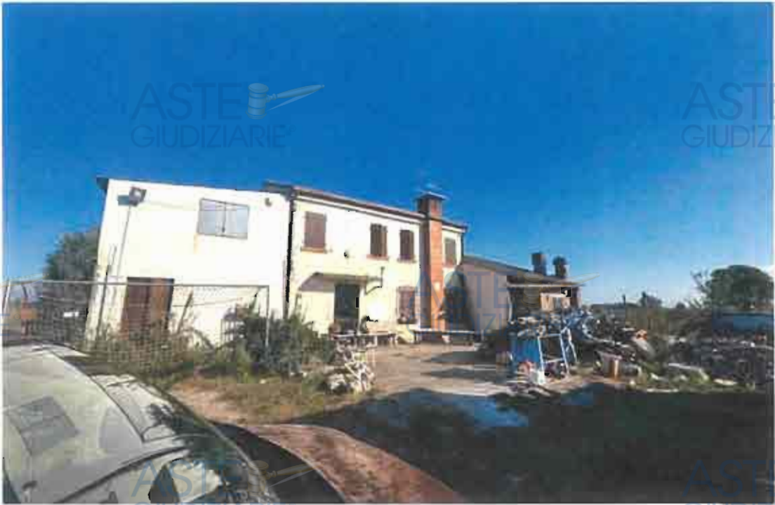
FOTO 3 - Fronte sud 1.a
