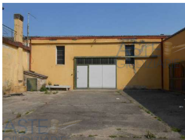
Capannone sub 4 e ingresso a lato garage sub 6
