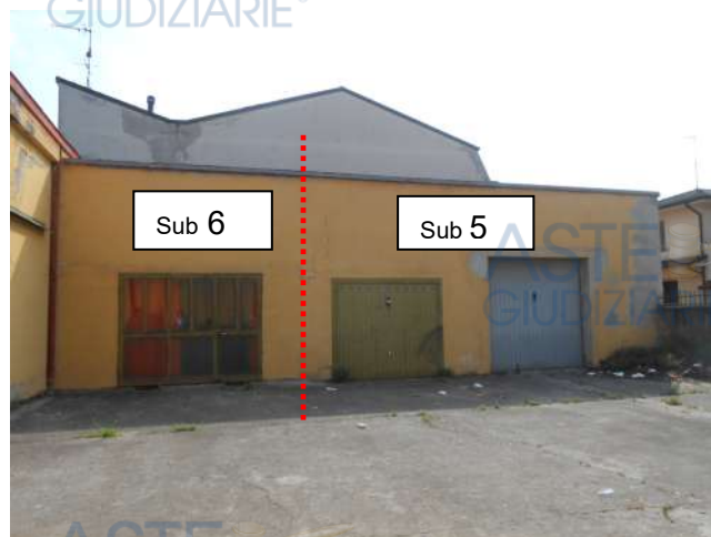
Ingresso al sub 5 e sub 6 garage
