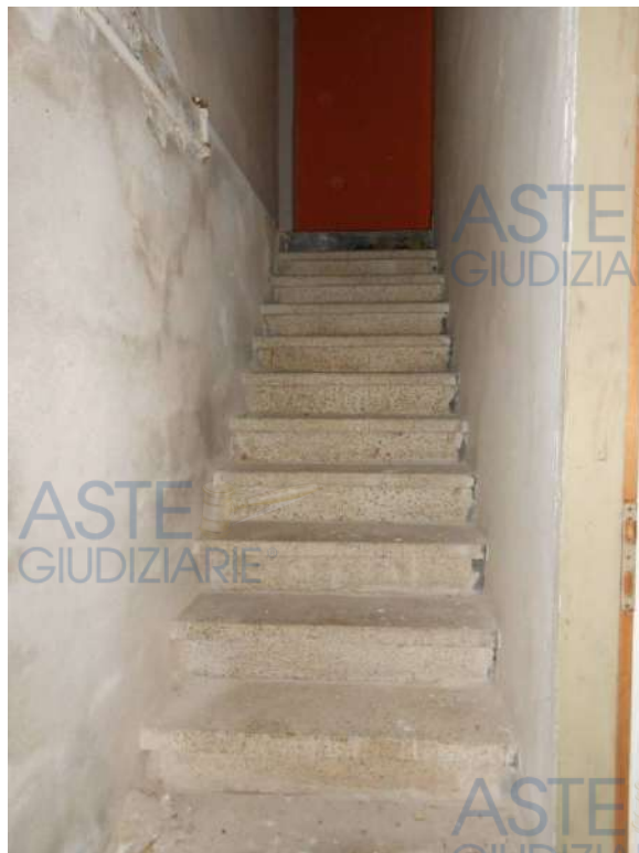
Scala che porta all'interrato
