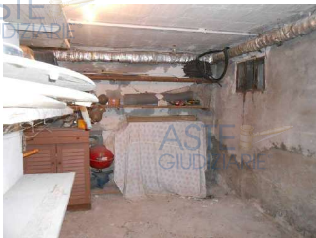
Piano interrato cantina
