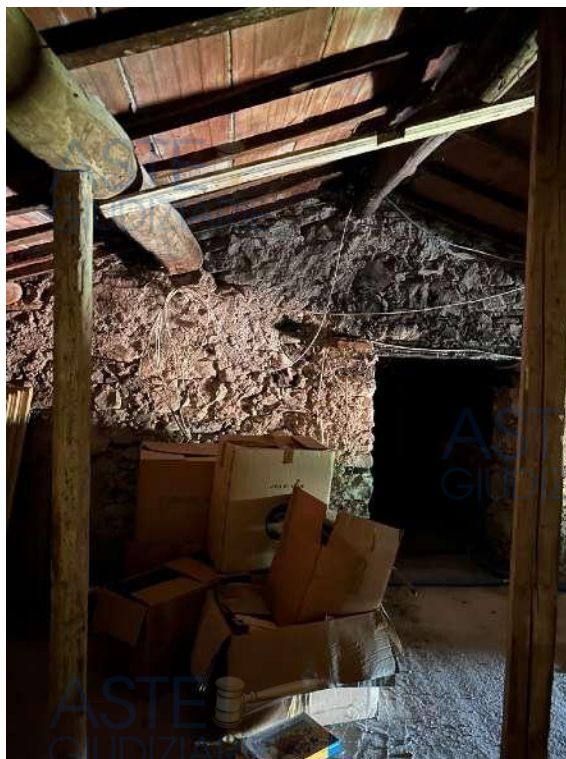
FOTO 22 - piano secondo sottotetto
