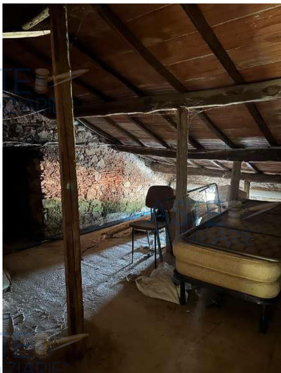
FOTO 21 - piano secondo sottotetto
