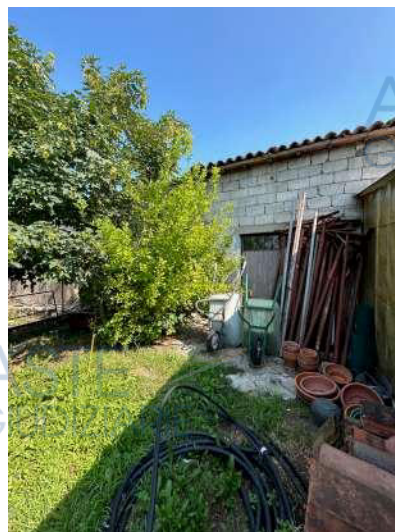
Pollaio ingresso sud - Area Urbana sub. 31
