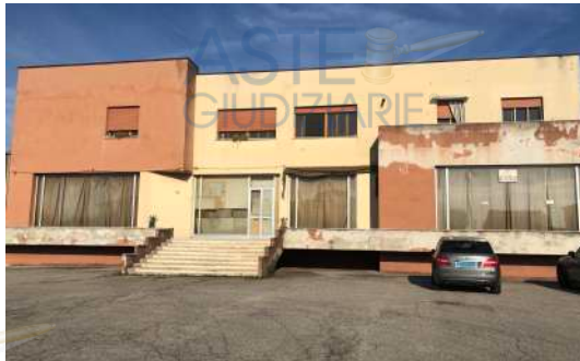
Foto 1 – Facciata da Via Ecce Homo
