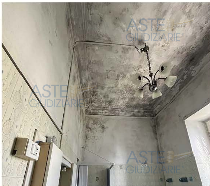
IMMAGINE 10 – MUFFE SU PARETI E SOFFITTO
