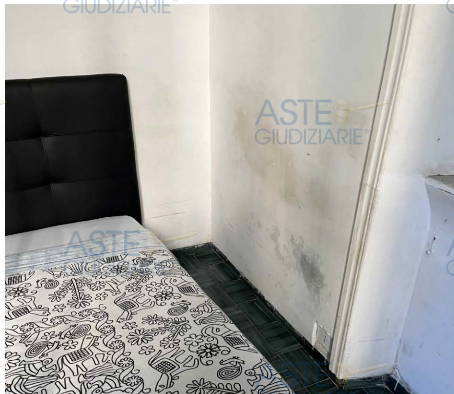
IMMAGINE 12 – MUFFE DA UMIDITA' DI RISALITA
