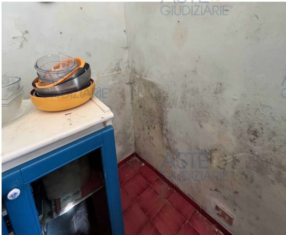
IMMAGINE 11 – MUFFE DA UMIDITA' DI RISALITA
