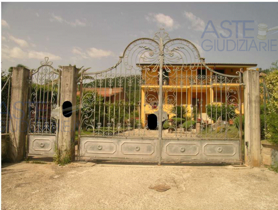
FOTO CANCELLO INGRESSO AGLI IMMOBILI CONTRADA MAIOTINI N. 66
