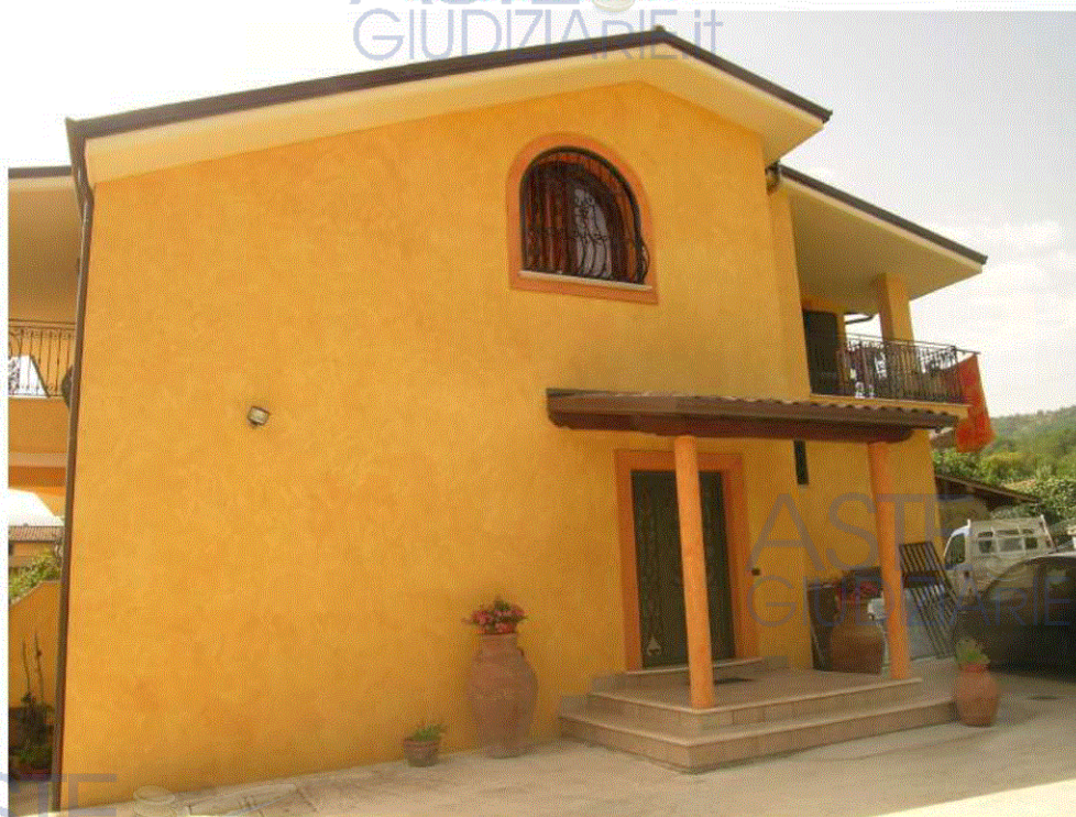
FOTO FACCIATA LATERALE CON L'INGRESSO DELL'APPARTAMENTO INT. 2 PIANO PRIMO
