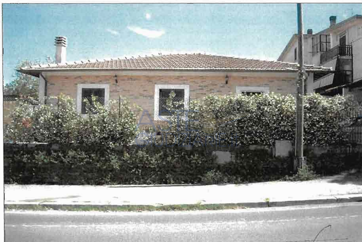
Comune di Rocca Priora Loc. Colle di Fuori Via San Cesareo civ.42
