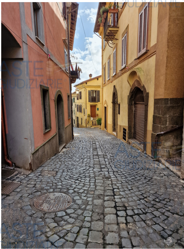
FOTO FACCIATA EDIFICIO
