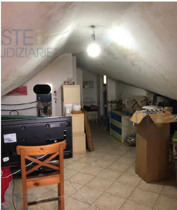
Figura 11_Vista soffitta. F.* P.IIa * sub.*
