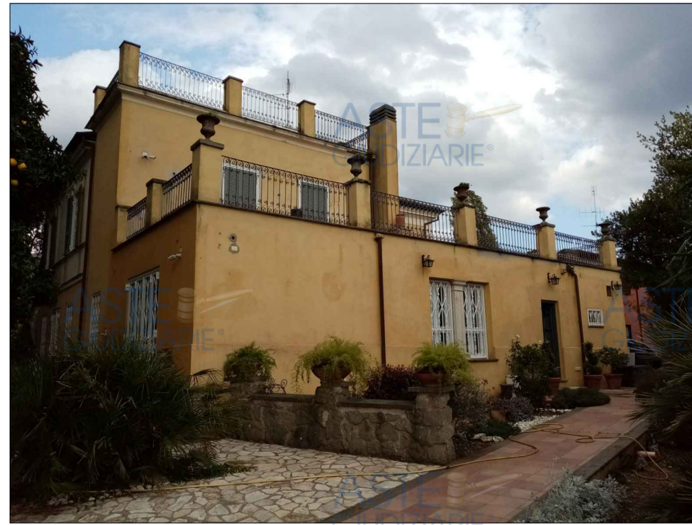
FOTO N. 3 - Fg. 63 p.la 29 sub. 504, LATO SUD
