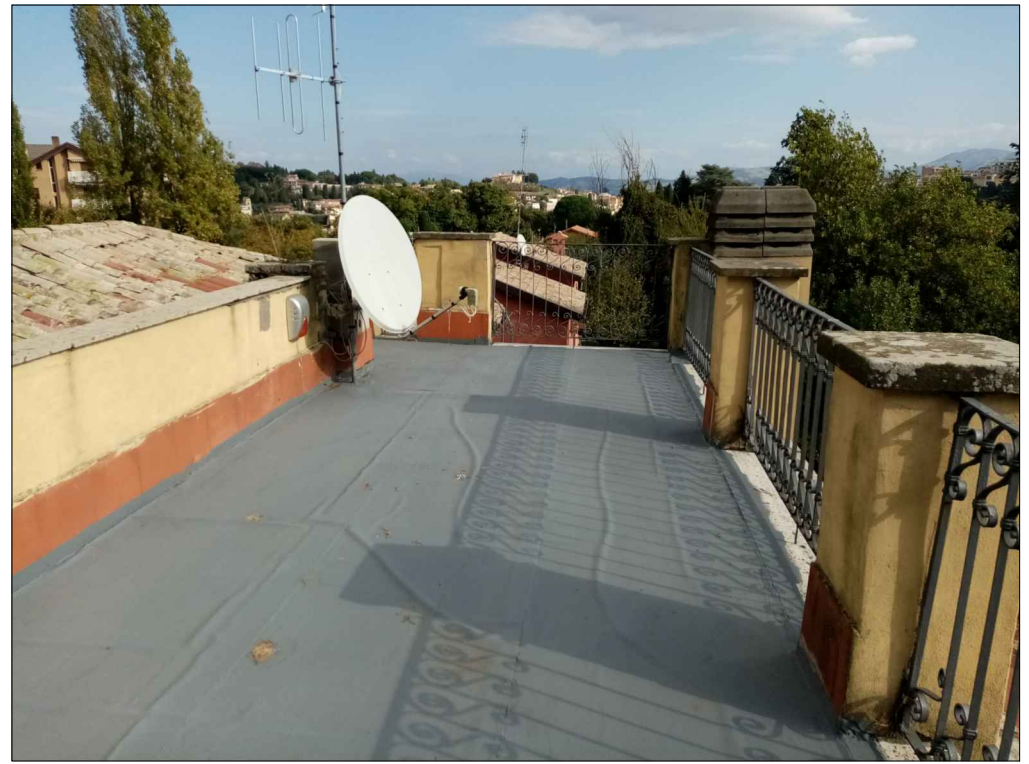
FOTO N. 7 - Fg. 63 p.la 29 sub. 504, TERRAZZO 2, LIVELLO COPERTURA
