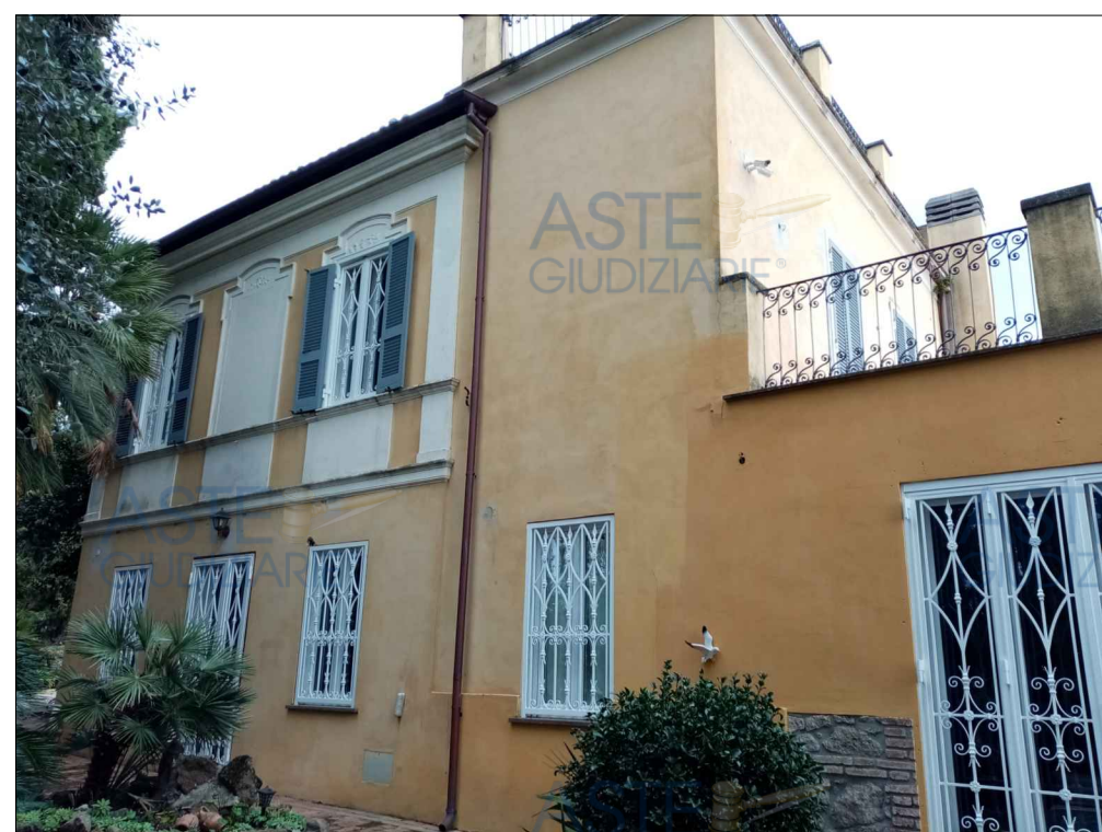
FOTO N. 4 - Fg. 63 p.la 29 sub. 504, LATO OVEST
