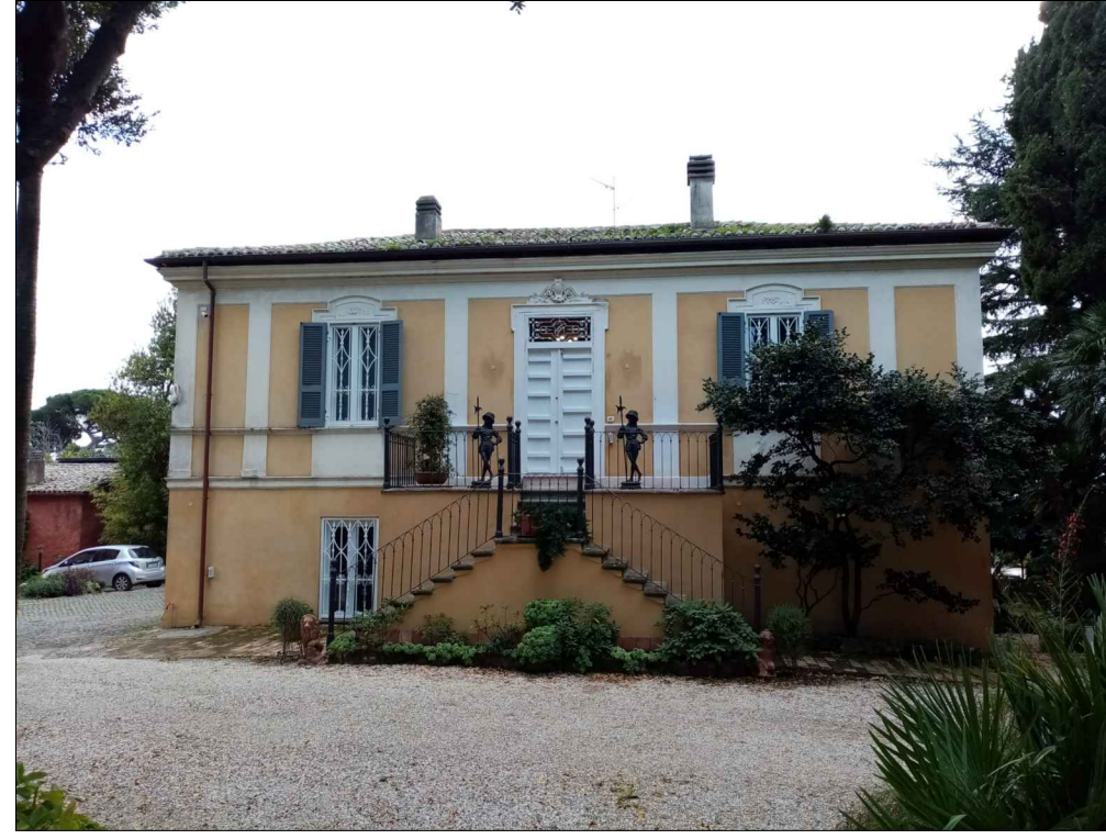
FOTO N. 1 - Fg. 63 p.la 29 sub. 504, LATO NORD
