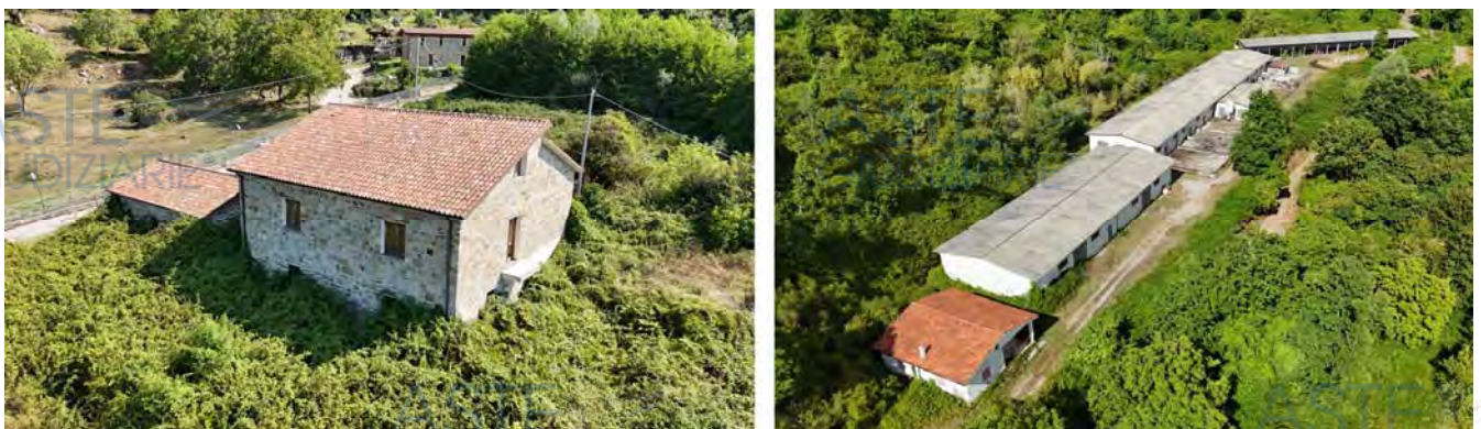
Figura 3 – A sinistra il fabbricato ed annesso laboratorio insistente sulle particelle 88/89 del foglio 31 – Nella foto a destra il complesso zootecnico insistente sulla particella 1 del foglio 33
