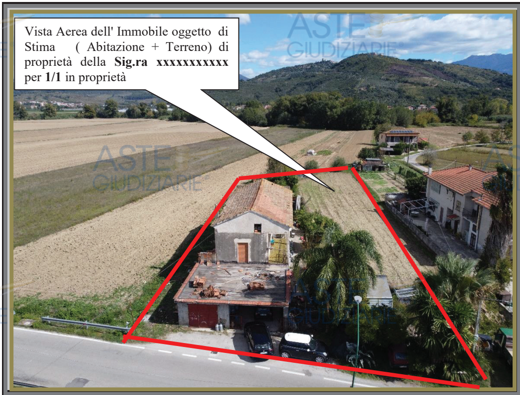
Figura 3: Vista aerea dell'immobile oggetto di stima con indicazione dell'ingresso dalla Via xxxxxx
