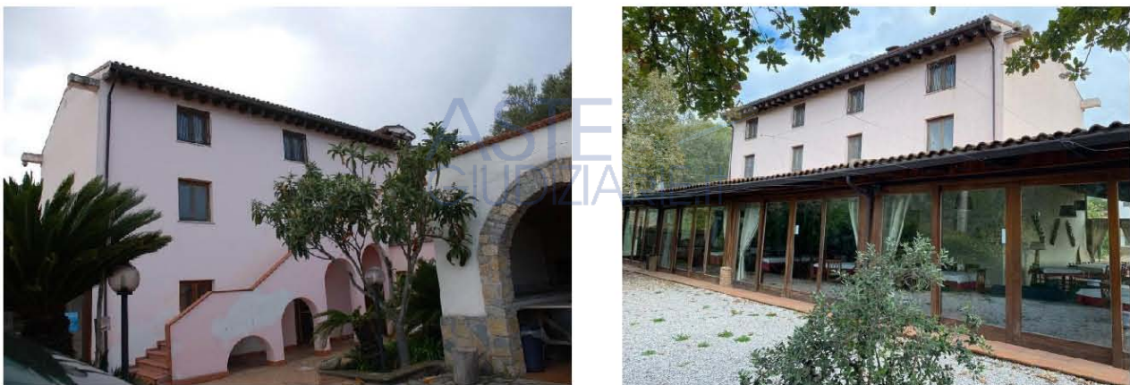
Figura 7 - fabbricato foglio 23 p.la 262 cat. D2
