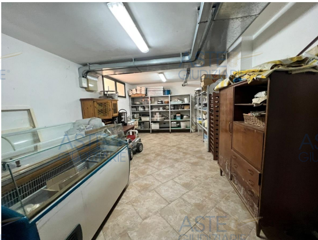
RILIEVO FOTOGRAFICO: interni deposito seminterrato del Fabbricato esecutato part. 251.
