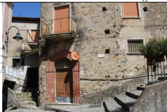
Figura 7- Accesso al fabbricato
