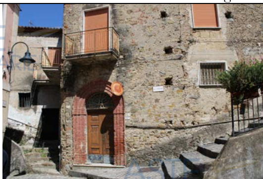
Figura 2- Accesso al fabbricato
