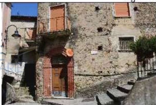
Figura 17- Accesso al fabbricato
