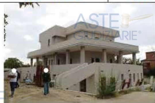
Figura 27- Fabbricato in corso di costruzione
