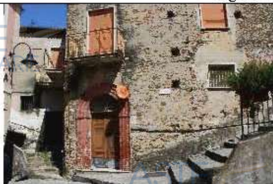
Figura 12- Accesso al fabbricato
