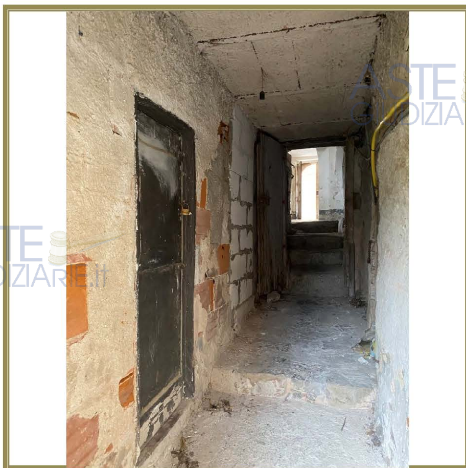
Figura 11: Vista della zona di accesso ai locali deposito ( corridoio ) con la porta di accesso al sottoscala
