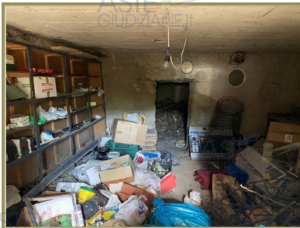
Figura 12: Vista interna dei locali deposito al Piano Seminterrato
