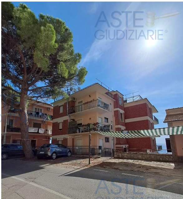
Ingresso pedonale con accesso lungo la S.S. 267
