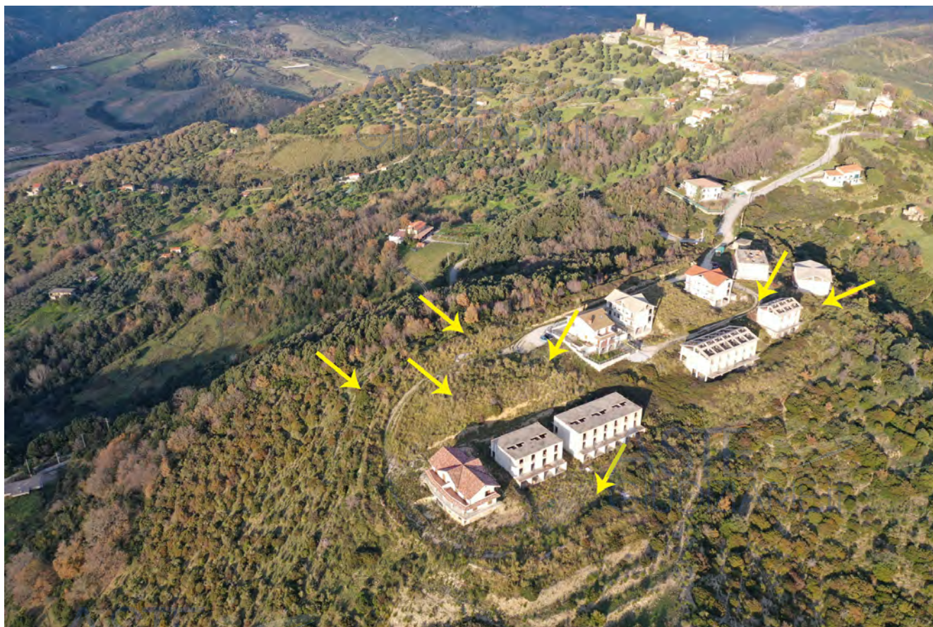
Figura 3 - Foto da drone con indicazione delle aree pignorate
