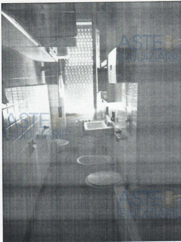
FOTO 4 – alloggio – piano secondo – bagno
