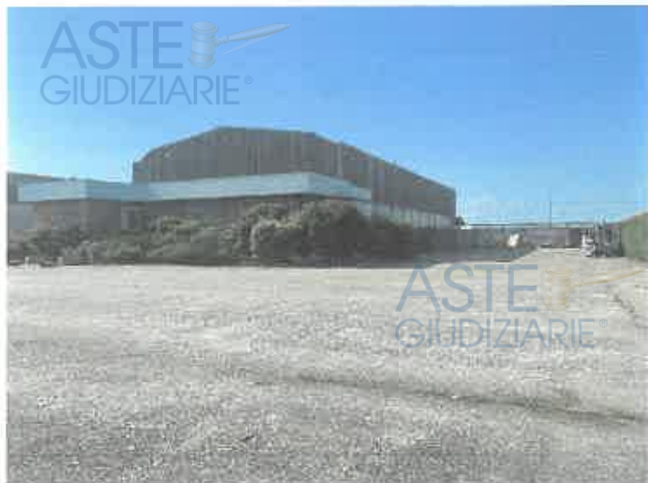
Esterno lato a sud con uffici e salone e piazzale
