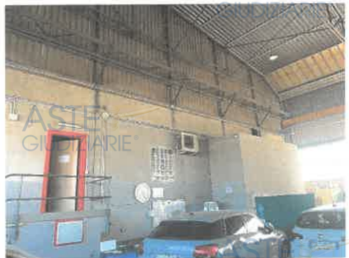
Interno salone lato uffici
