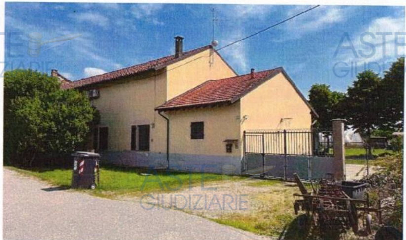
VISTA FABBRICATO DA VIA ALBONESE CON CANCELLO CARRAIO/PEDONALE DI ACCESSO ALLA PROPRIETA'
