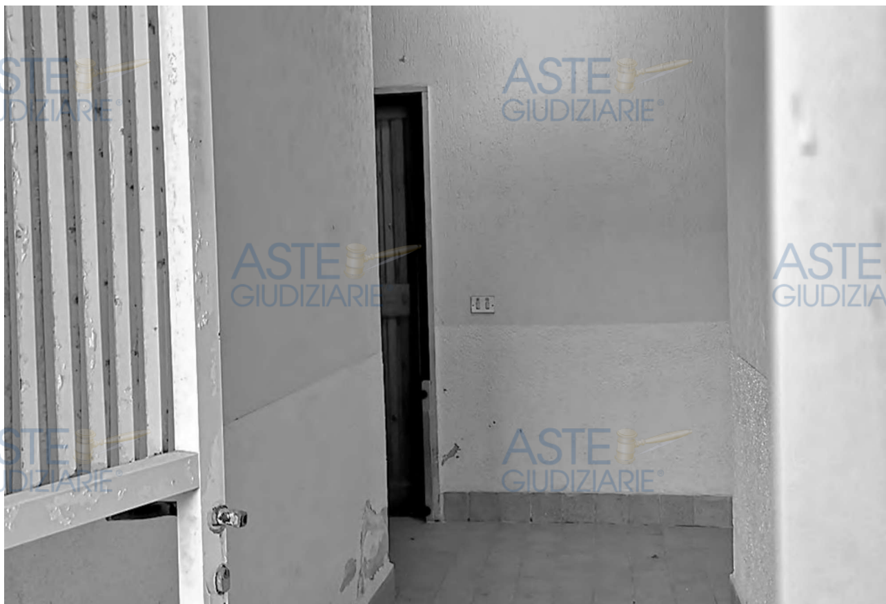
Veduta del corridoio di ingresso comune
