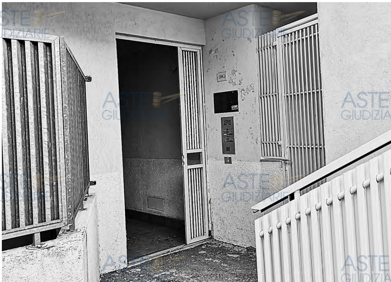
Veduta della porta di ingresso al corridoio comune
