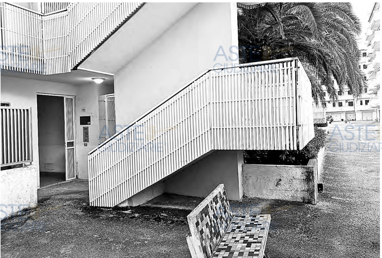
Veduta della scala condominiale
