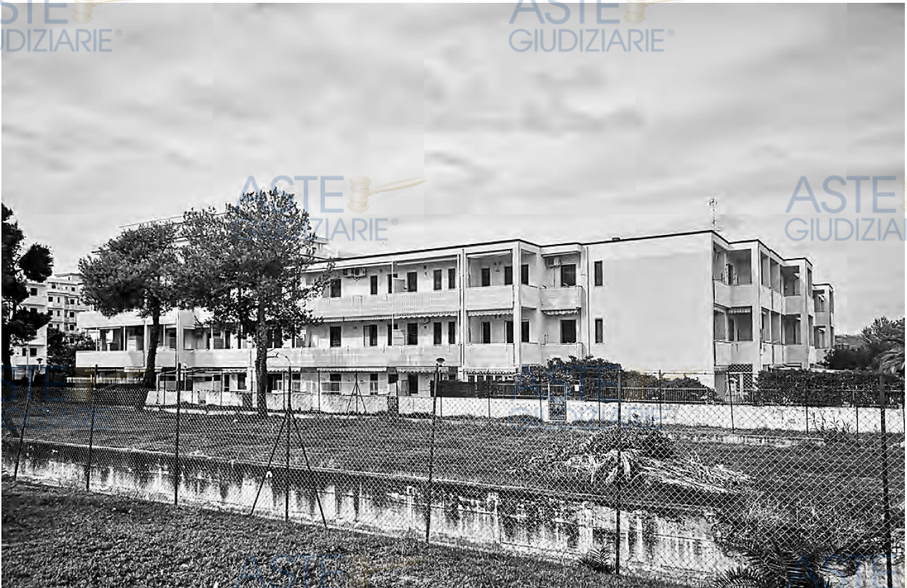
Veduta della facciata del fabbricato
