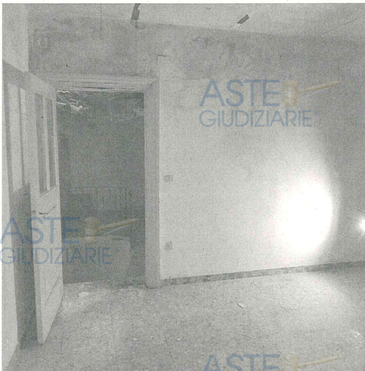
Foto n° 5 di 5 – Vista interna Piano Secondo
