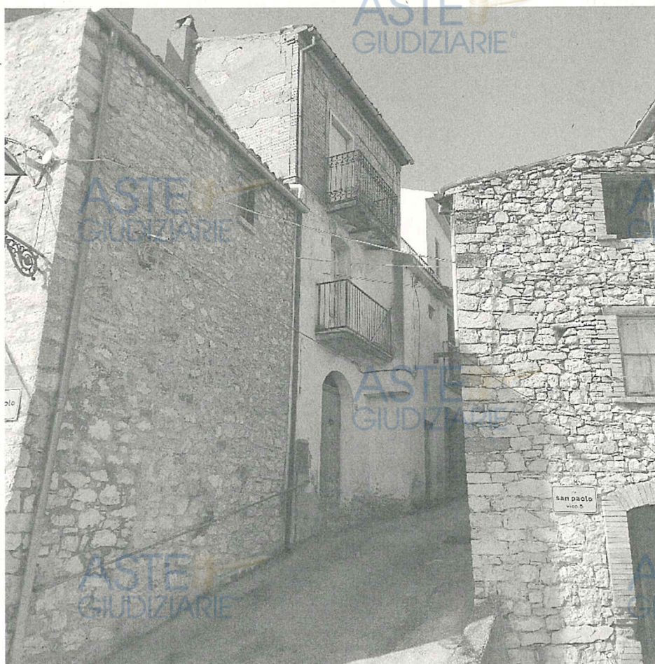
Foto n° 1 di 5 – Vista esterna del fabbricato
