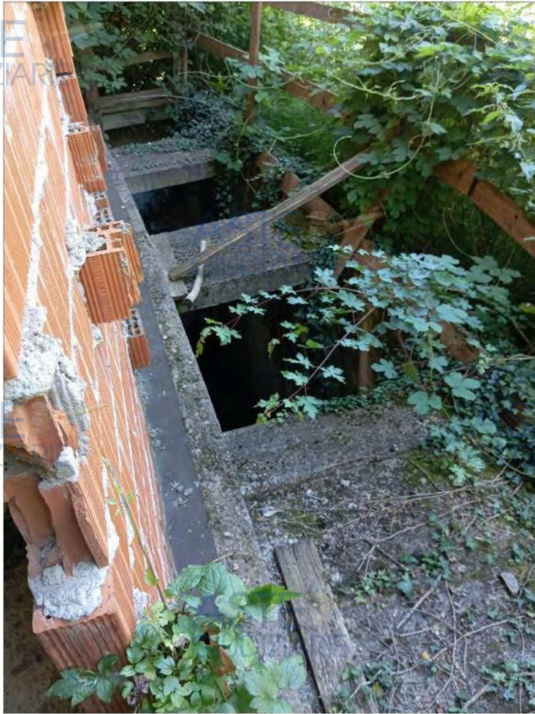
Intercapedini del piano cantinato
