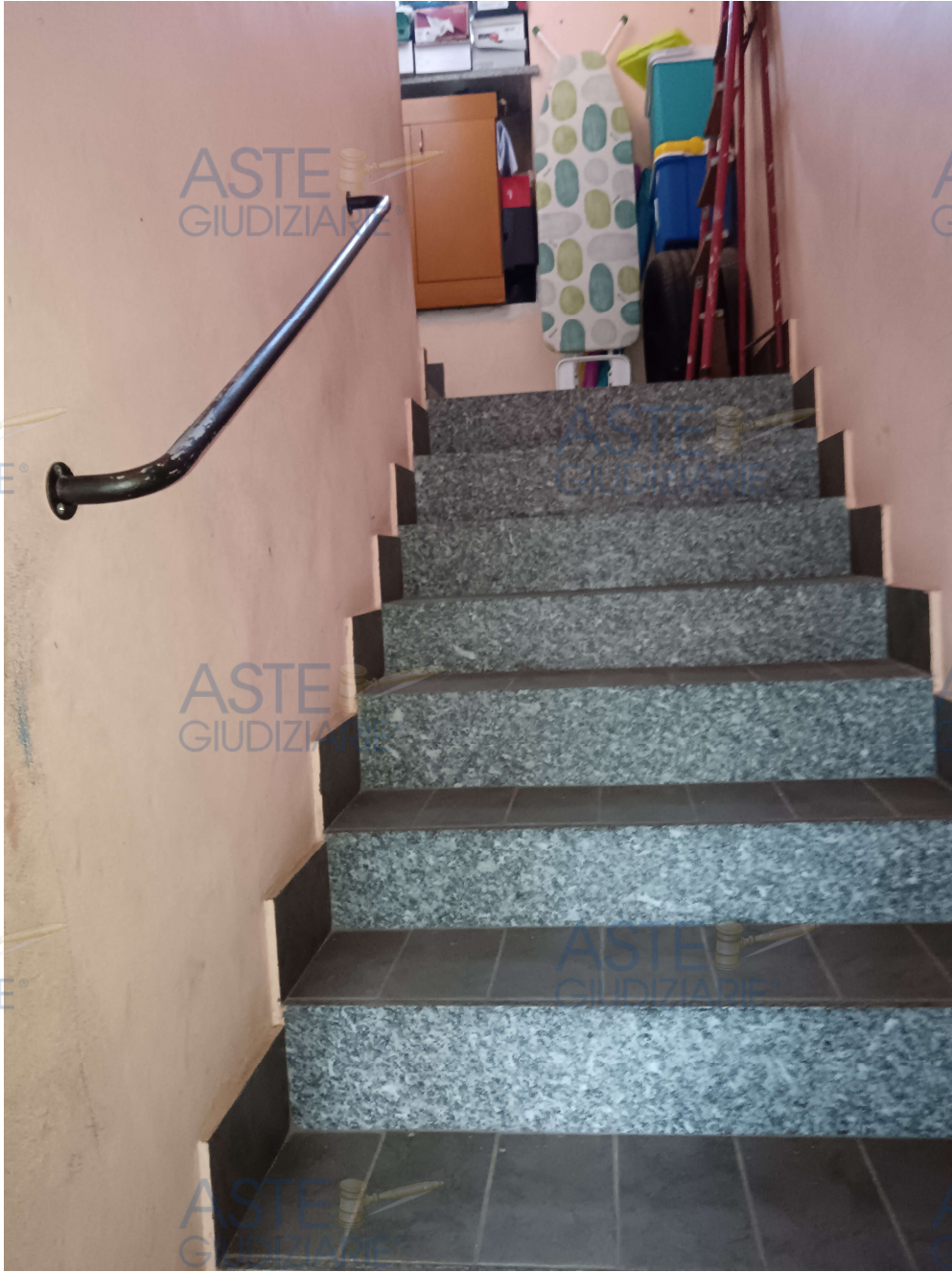
SCALA DI ACCESSO AL PIANO SUPERIORE
