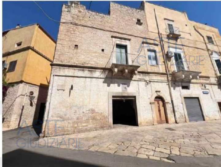
Prospetto su Via Tiziano Vecellio
