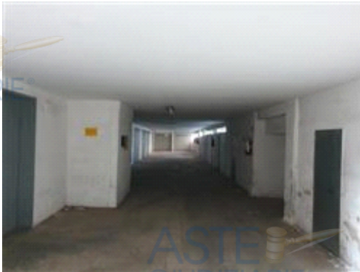
corsia di scorrimento dell'interrato e porta di ingresso al deposito
