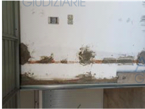
finiture delle pareti verticali
