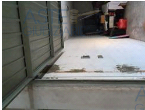
particolare della porta di ingresso
