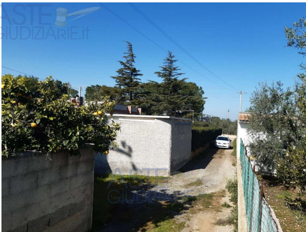
Corpo n.1 – Immobile da Demolire
