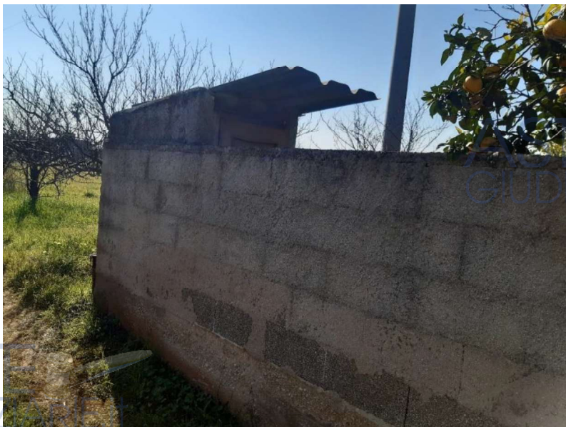
Corpo n.2 – Immobile da Demolire
