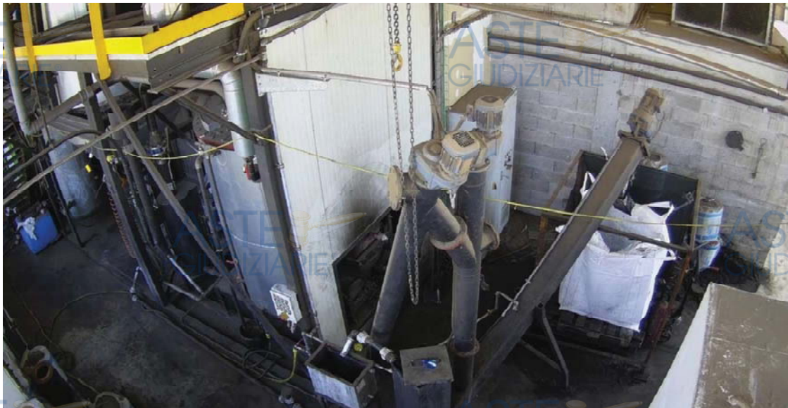
Figura 13 - Vista del gassificatore e del sistema di estrazione del biochar
