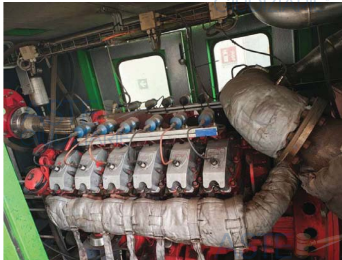
Figura 4 - Motore a Biogas – Liebherr Vascigliano 1
