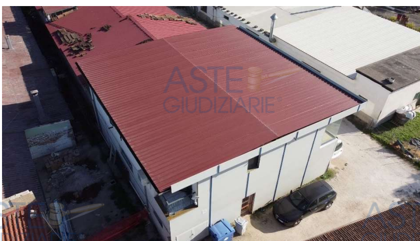
Foto 12 Vista copertura lato Nord- Ovest
