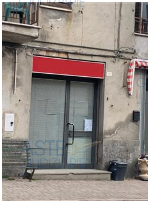
Vista di dettaglio della vetrina di ingresso
