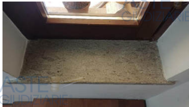
Soglia infissi esterni_Piano T-1°_22
