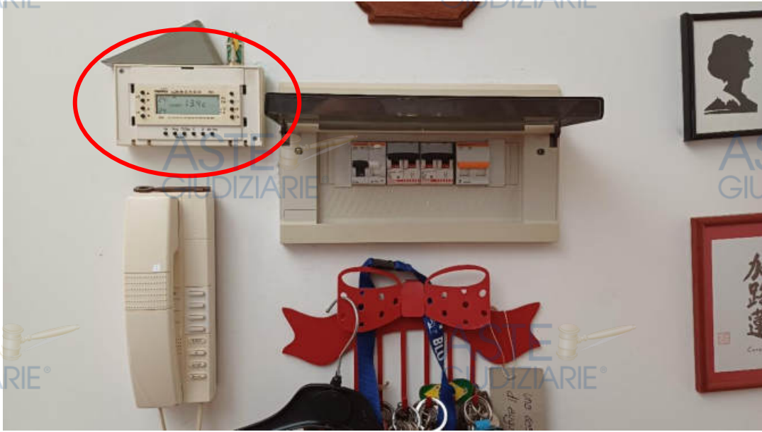
Impianto termico_Cronotermostato_10
