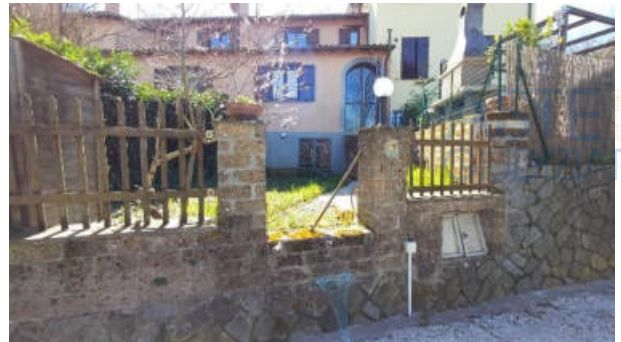
Recinzione fronte posteriore_10
