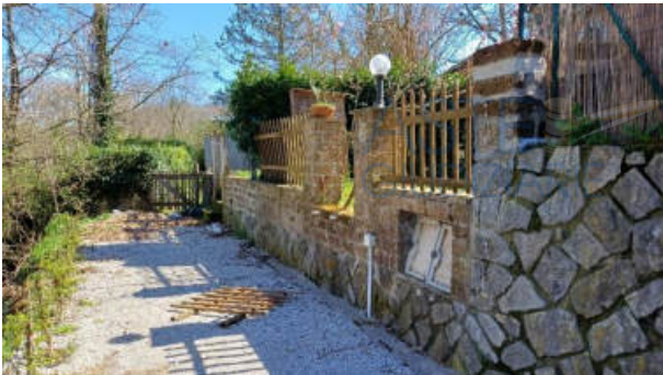
Recinzione fronte posteriore_09
