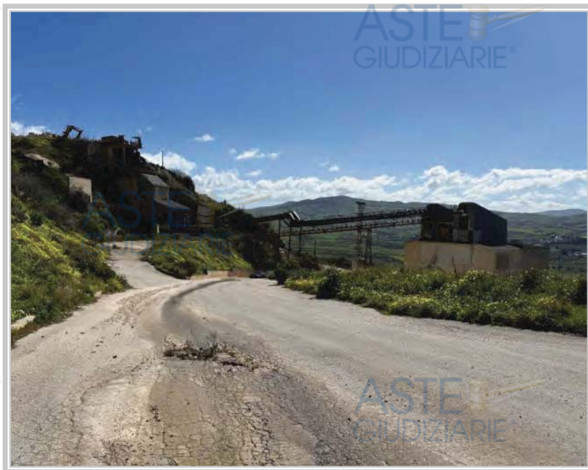
Foto 6 : Impianto di frantumazione e selezione di materiali inerti (anno di ripresa 2024).
