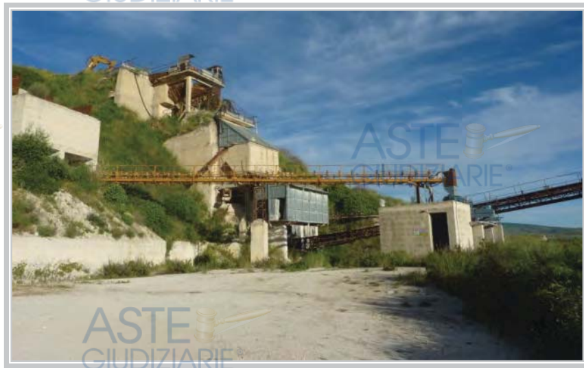
Foto 5 : Impianto di frantumazione e selezione di materiali inerti (anno di ripresa 2016).
