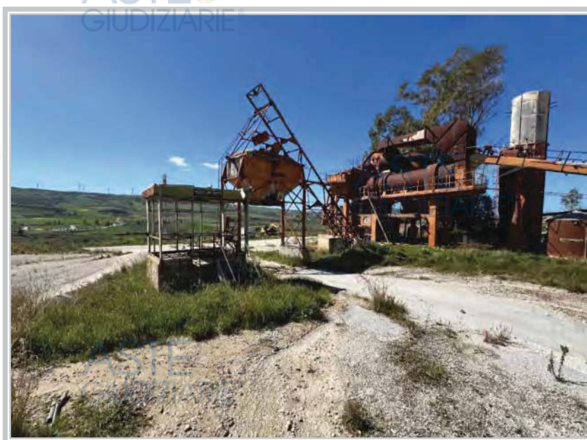
Foto 4 : Vista dell'impianto di produzione di conglomerati bituminosi (anno di ripresa 2024).
