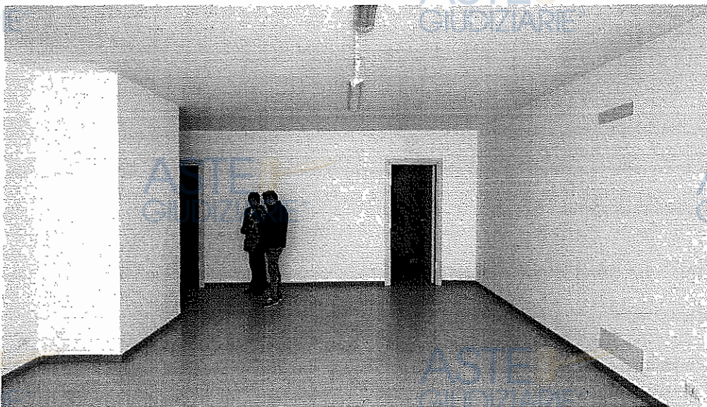
FOTO 2 - LOCALE INGRESSO SUB. 6
