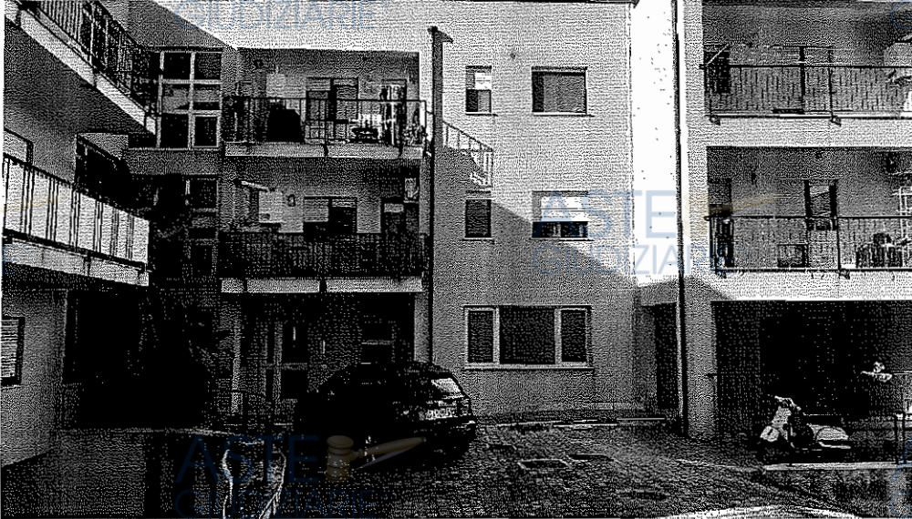
FOTO 1 - PORZIONE PROSPETTO VIA DON G. GIARDINA
